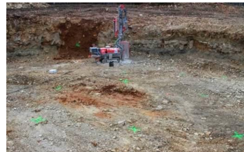
Foreuse géotechnique sur un chantier
