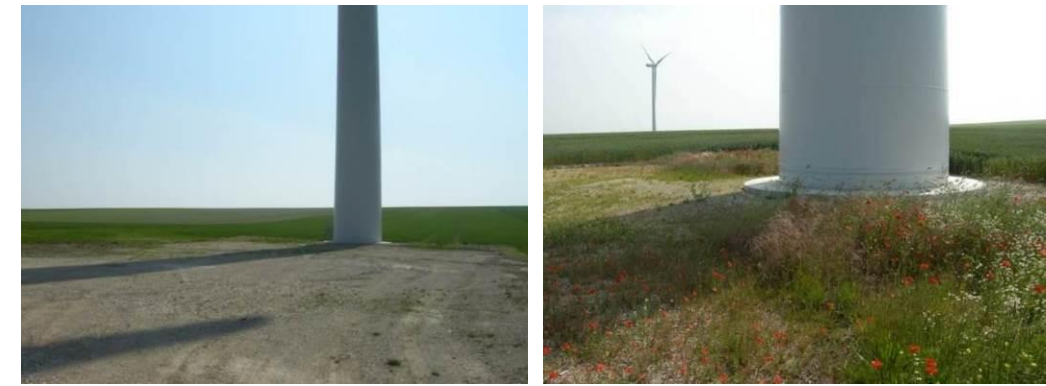
Exemple de types de revêtement au pied des éoliennes. A gauche, plateforme dépourvue de végétation (à favoriser). A droite, friche herbacée attractive se développant au pied d'une machine (à éviter)
