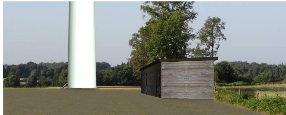
Figure 110 : Poste de livraison au niveau de l'éolienne E5
