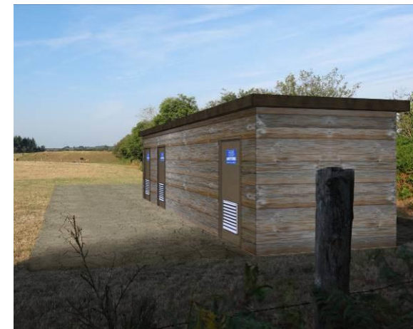
Figure 71 : Vue sur le poste de livraison le long de la RD 41
