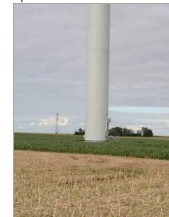
Parc éolien de Lesson (Vendée)
