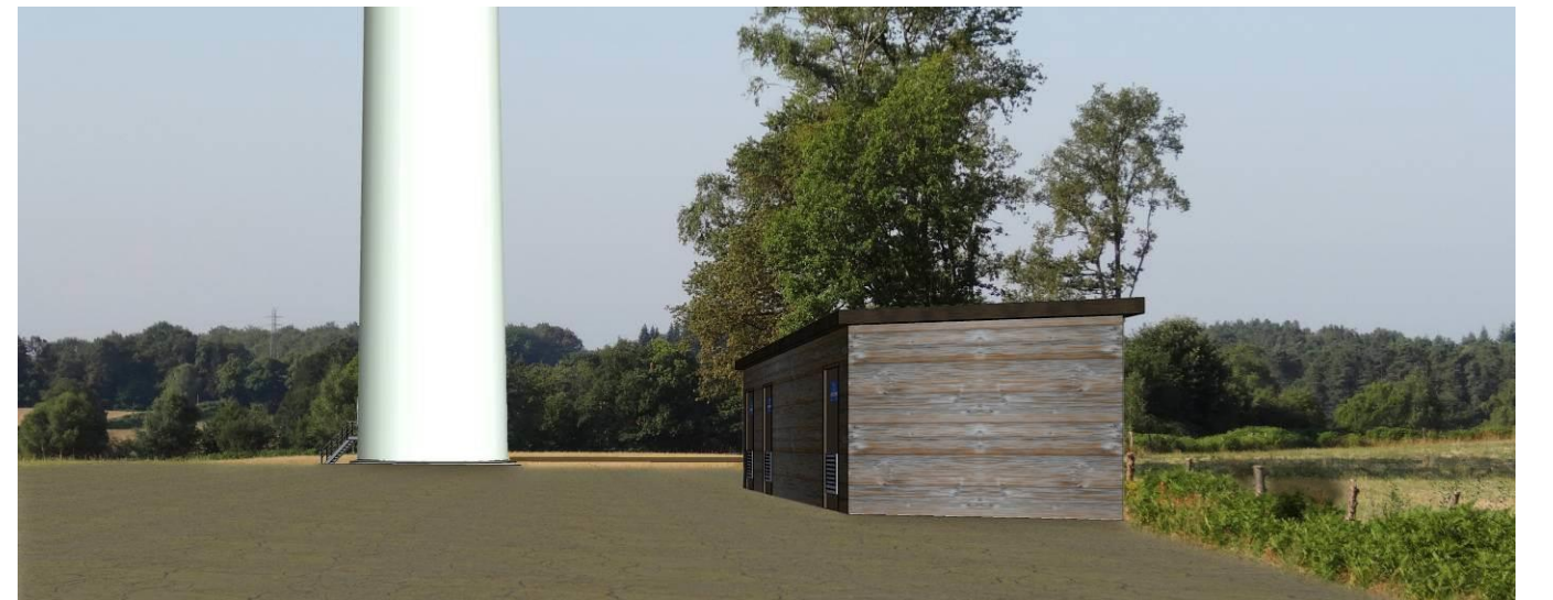
Figure 73 : Vue sur le poste de livraison à proximité de l'éolienne 5
