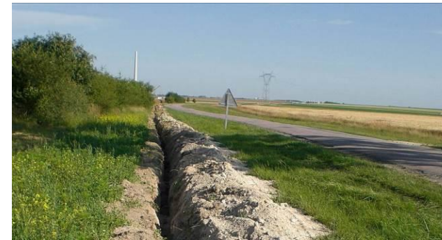
Figure 67 : Tranchée avant positionnement des câbles
