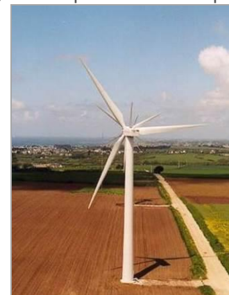
Vue aérienne du parc éolien de Plouarzel (Finistère)
