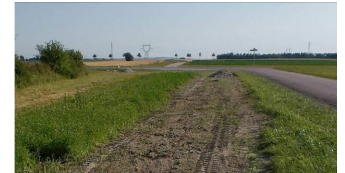
Figure 68 : Tranchée rebouchée après mise en place des câbles
