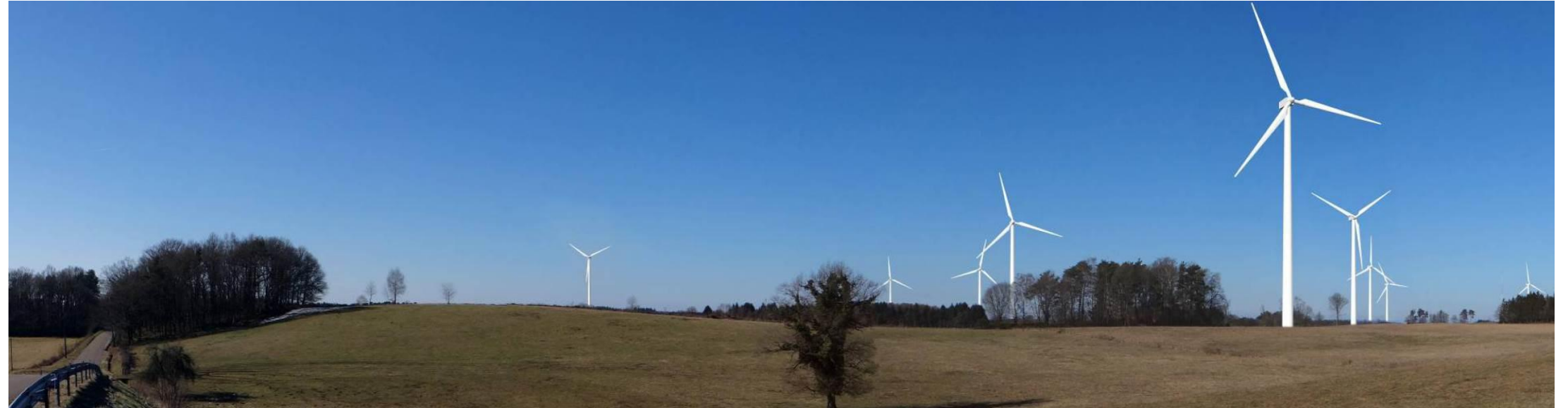
Figure 74 : Simulation à l'intersection entre la RD 41 et la RD 13, au niveau du lieu-dit Maisonneuve
