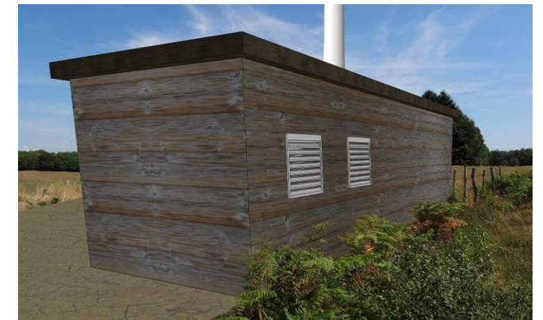
Figure 72 : Vue sur le poste de livraison à proximité de l'éolienne 10
